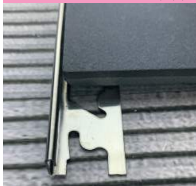
Chiusura perimetrale a pavimento/ Ground covering edging
