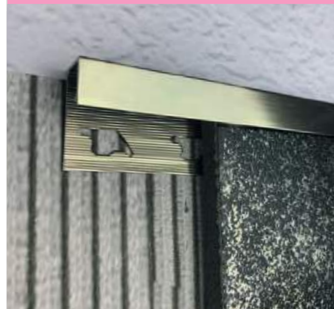
Chiusura perimetrale a muro / Wall covering edging
